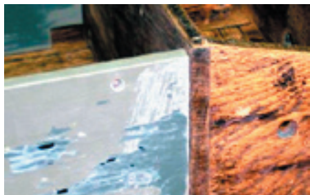
Bild 6. Originalmålningen består av två lager färg, en svart mycket tunn grundfärg och ett täckskikt i en blågrå färgton. Ett tredje skikt i en ljusare grå kulör har målats på senare.
