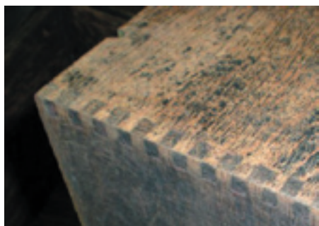
Bild 5. Skyddslådan för högspänningstransformatorn är försedd med sinkade hörn. Passformen är perfekt och limmet håller än. Kanske har äkta varmlim, baserat på kokta djurben och hudar, använts.
